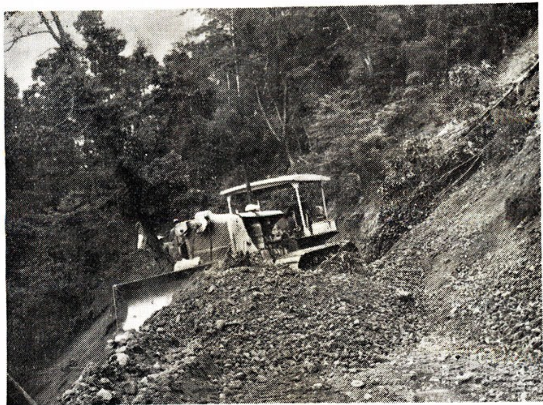
大雪山運材公路，正向深山拓展中，將來可到大雪山之巔。其開闢公路，亦使用新式堆土機，故其工程進展極為迅速。
