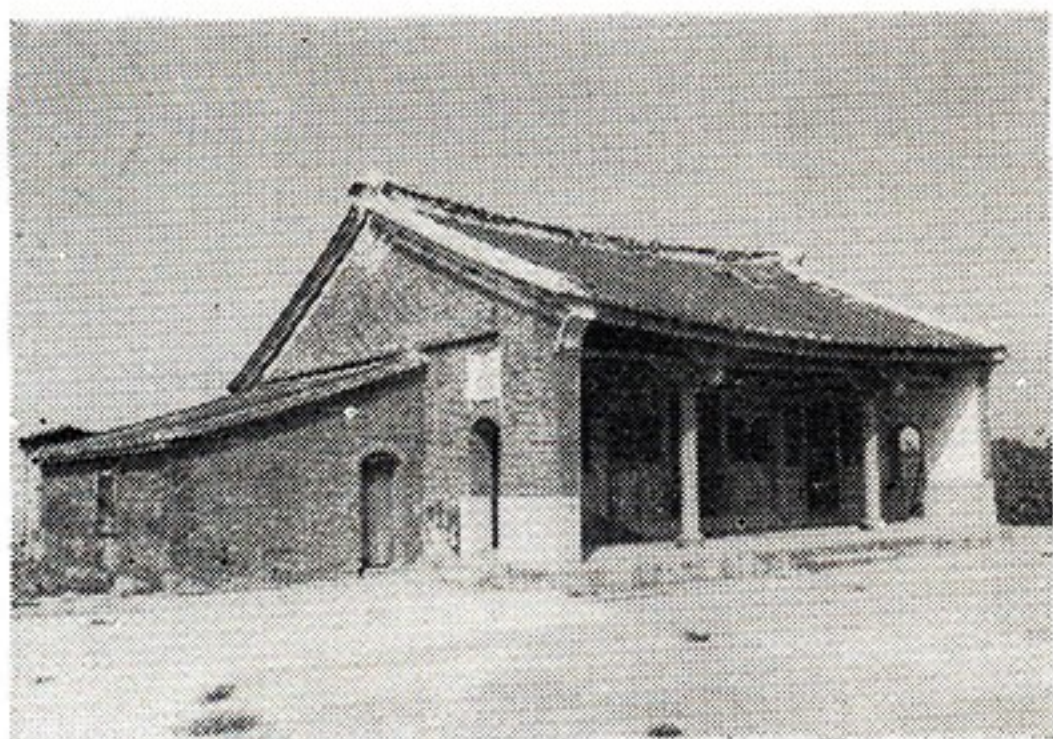
國仙三奉供，（宮祿永）宮福廣號八三庄後鄉港新 。間隆乾於建創，王
