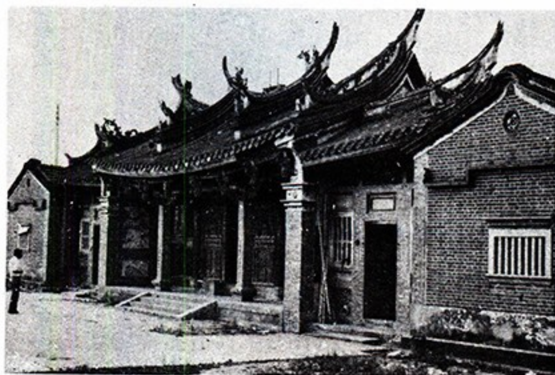
廟家廖張號〇一巷北安西區屯西
