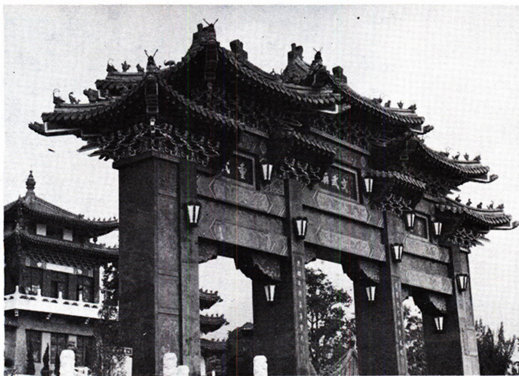
樓 牌 廟 武 文 潭 月 日
