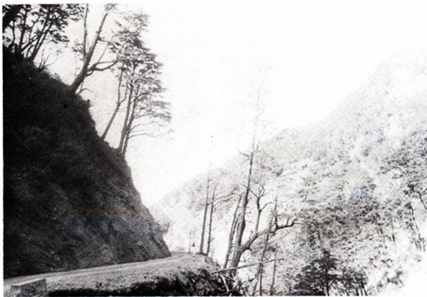
隧道東口附近
