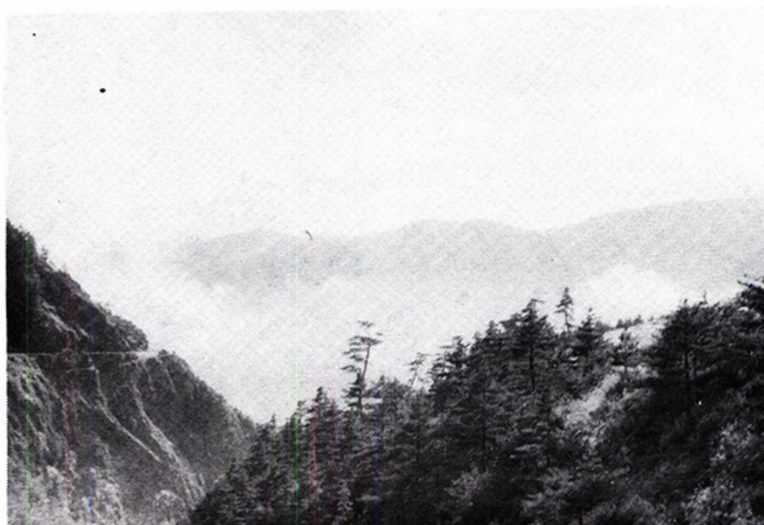
隧 道 東 口 附 近
