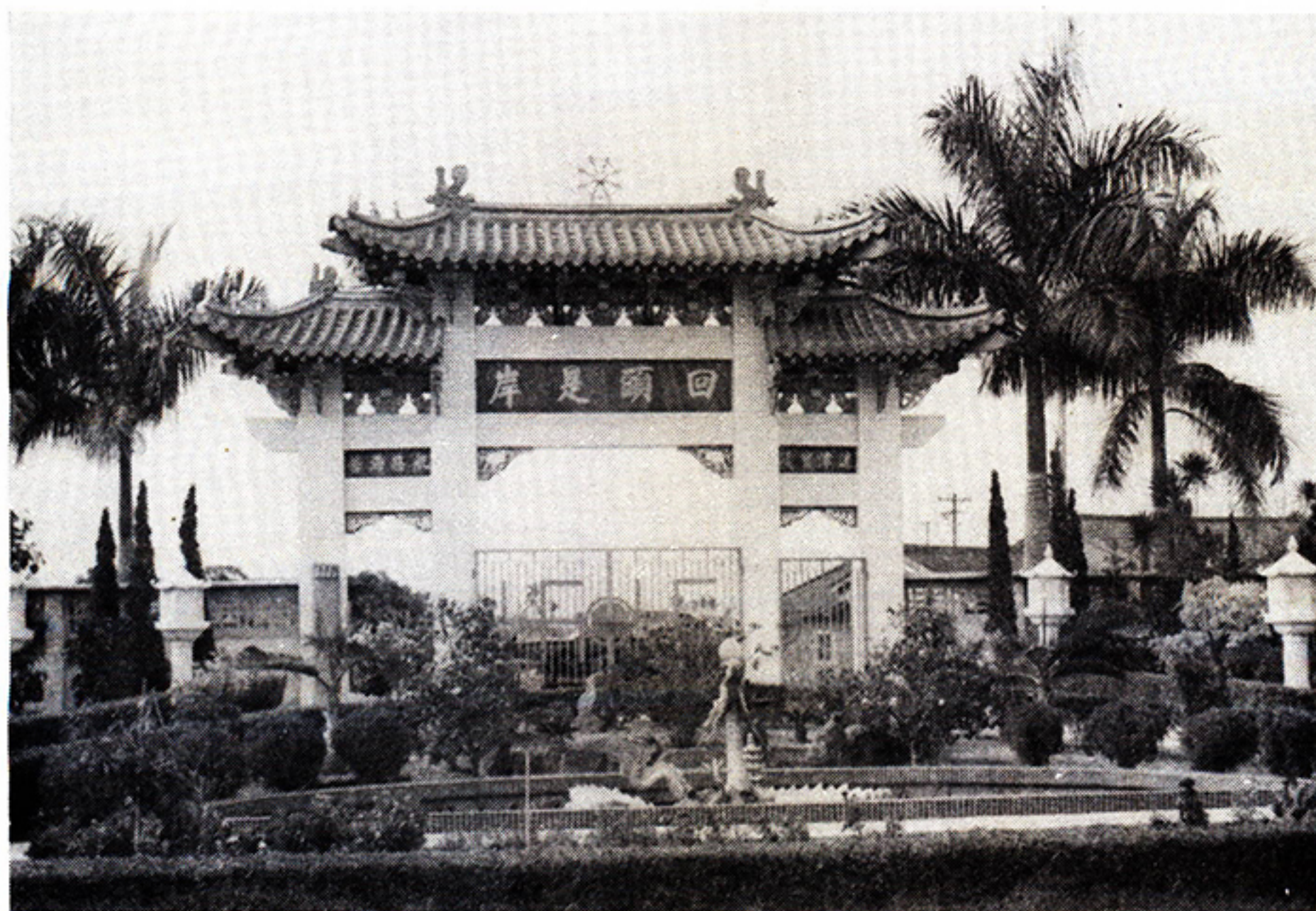
樓 牌 的 前 殿 寺 山 明
