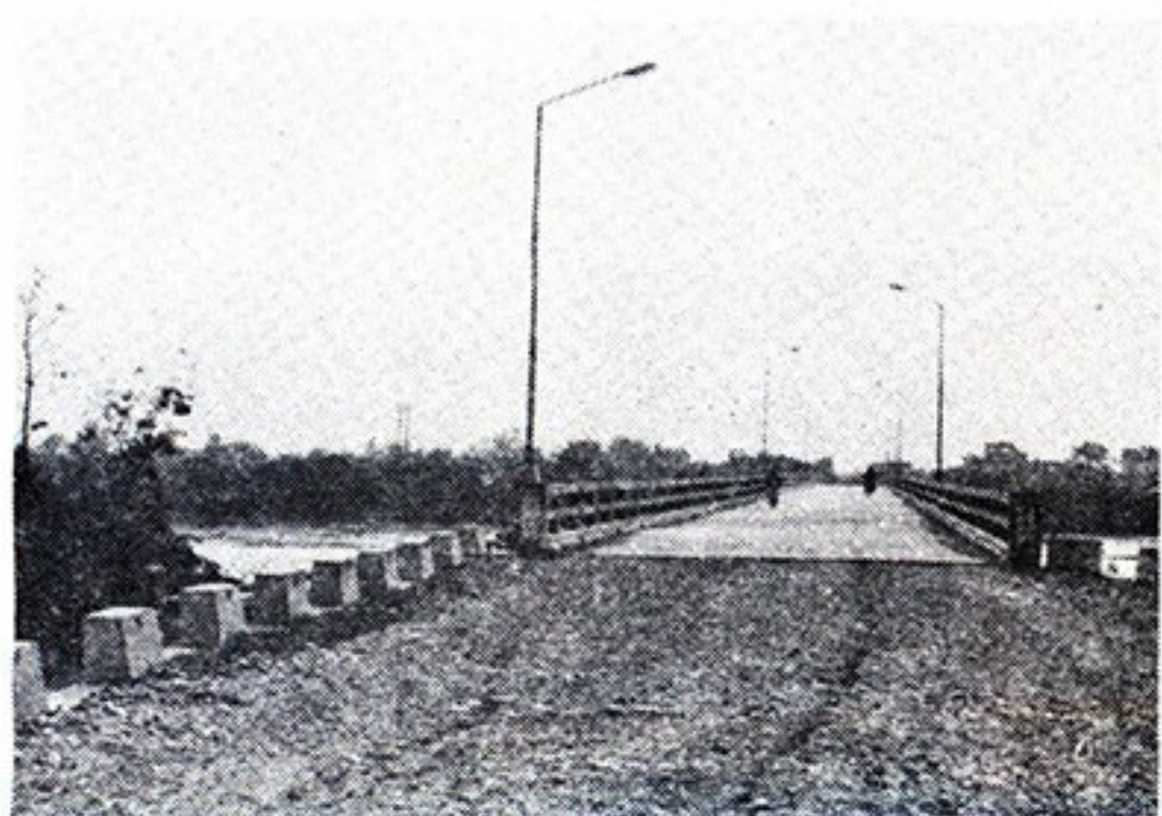
舊 港 通 往 南 寮 大 橋
