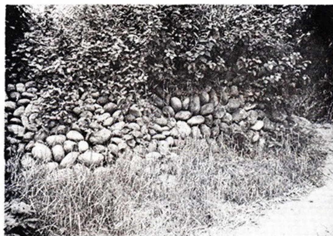
牆圍石的畔溪溪甲大外門厝基開
