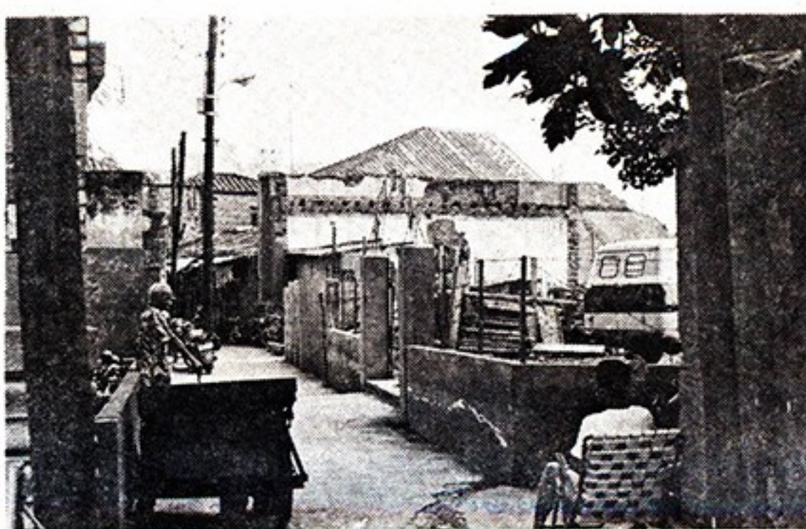
涼州街134巷古洋房的斷垣殘壁
