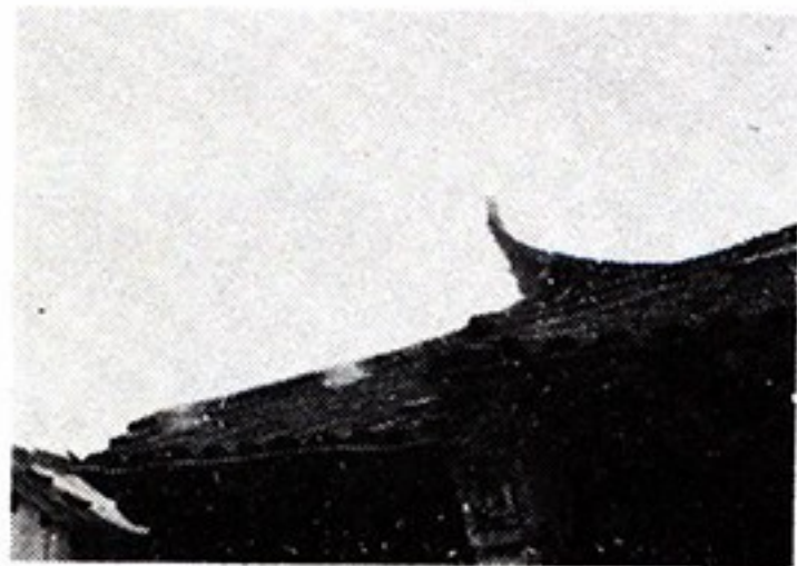
(二) 賴厝的屋頂
