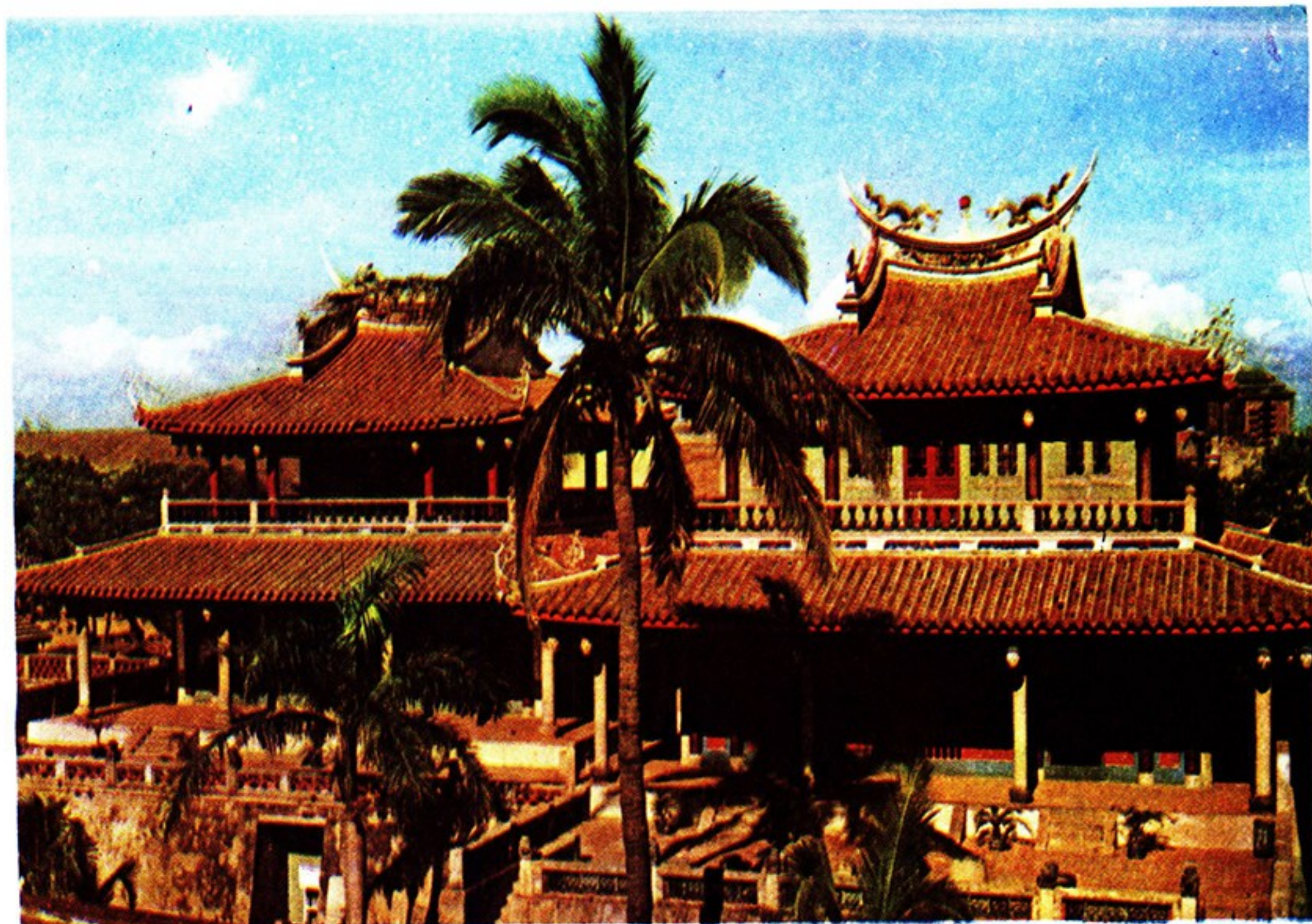
（圖5）民國三十三年修整之後，赤嵌樓，大士殿已拆除，顯出正面全貌
