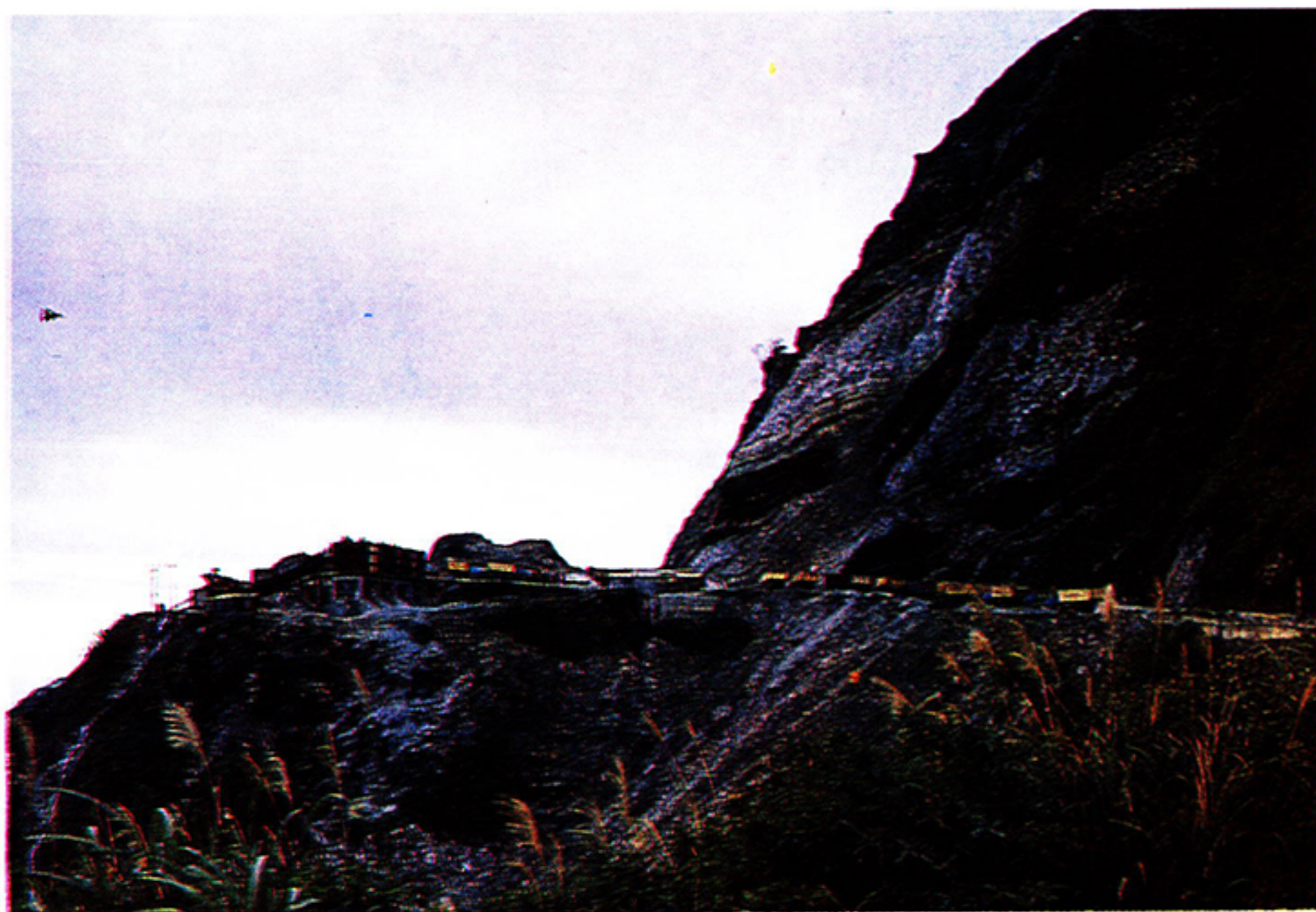
照片十：道路開挖土方應運至區外處理，以減少破壞。
