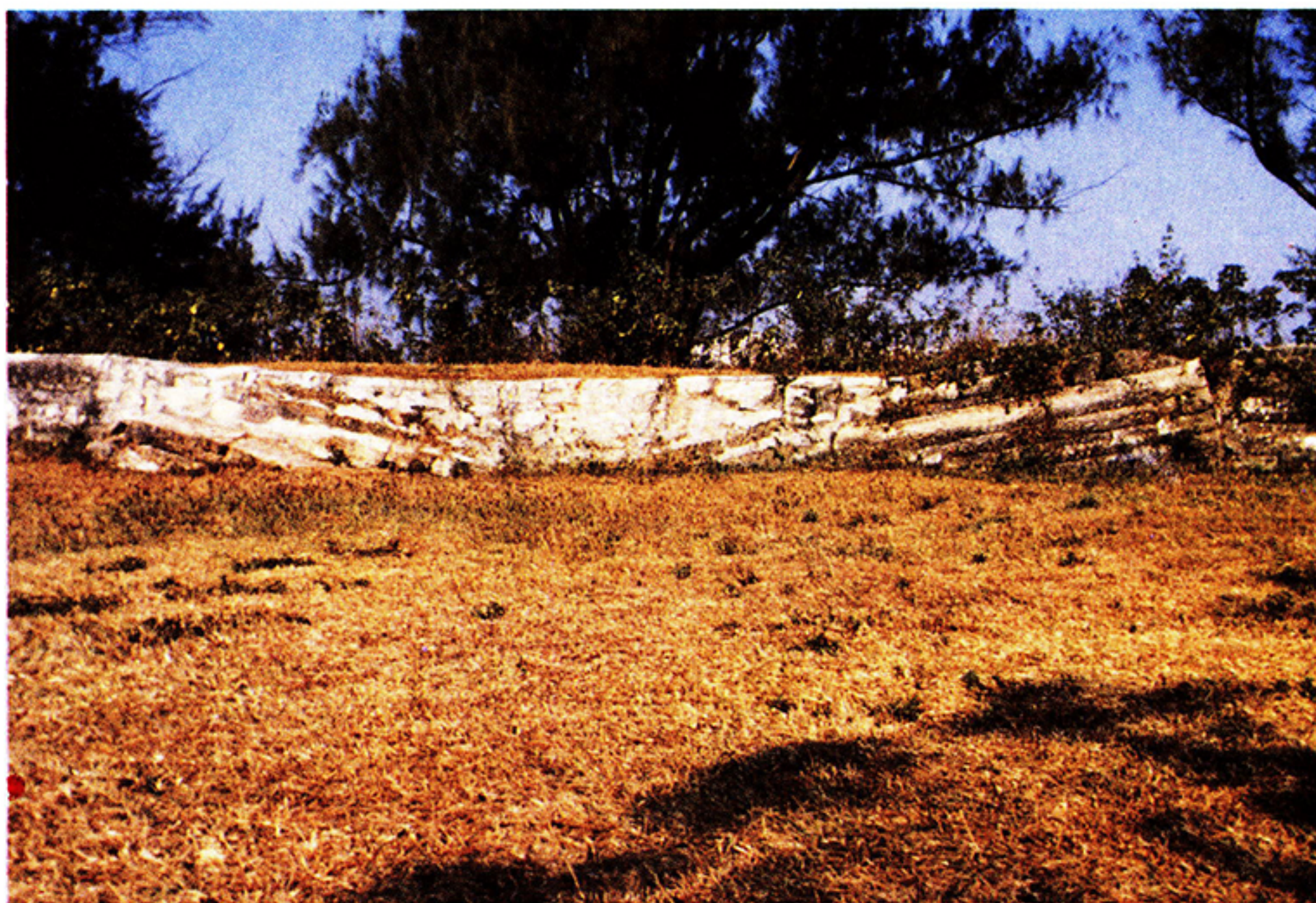
圖版四十二 城垣斷裂下陷情形，研判馬路下有兵房、藥子房，將作擇點開挖
