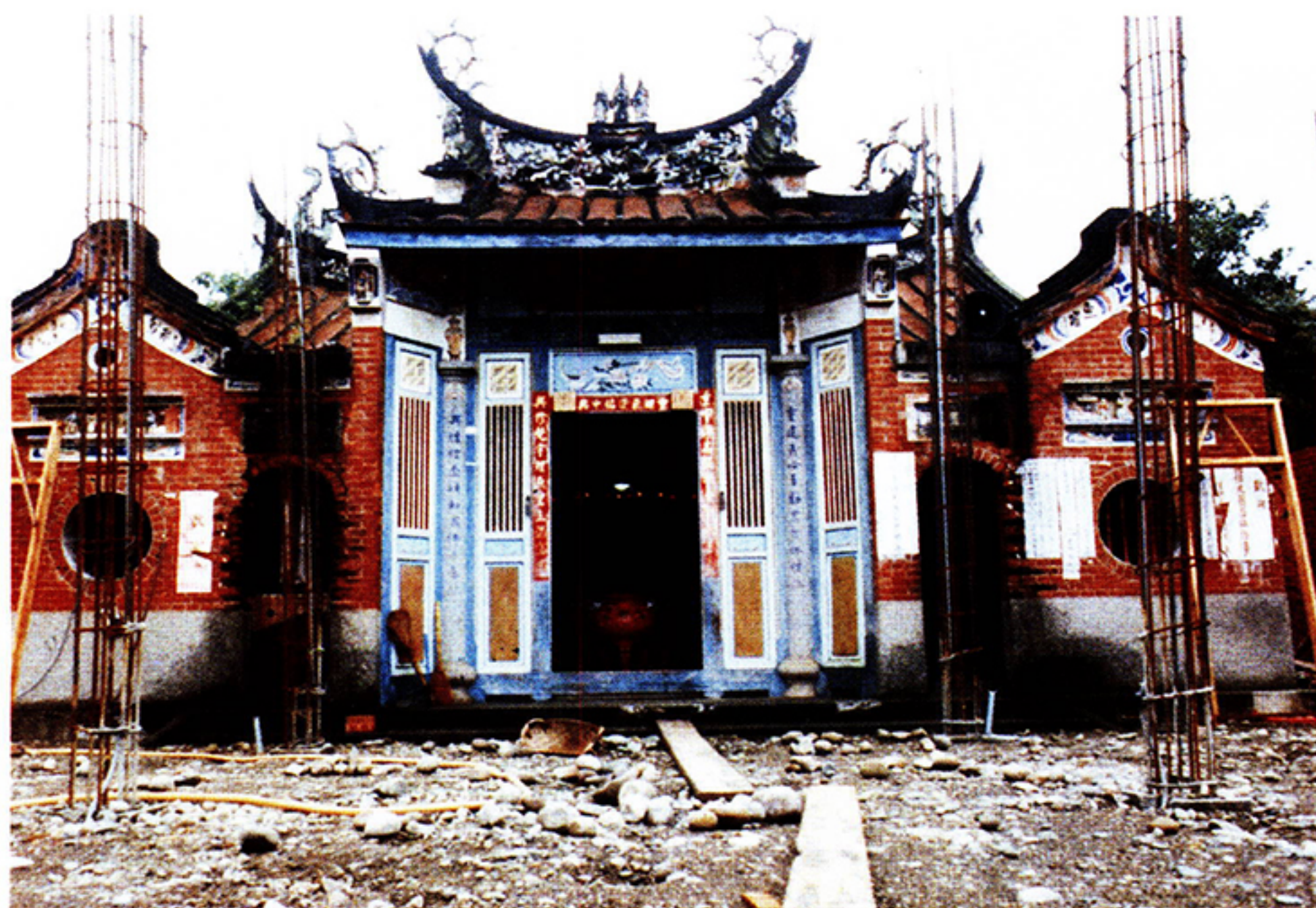
鯉魚尾巖改建前搶拍之舊貌
