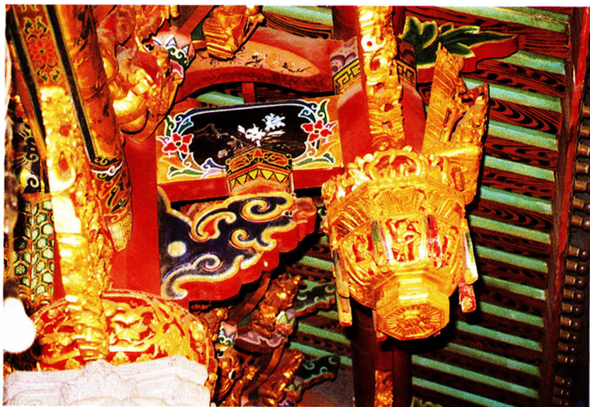
東港東隆宮三川殿步通出頭作豎材吊籃，員光出頭作螭虎拱。
