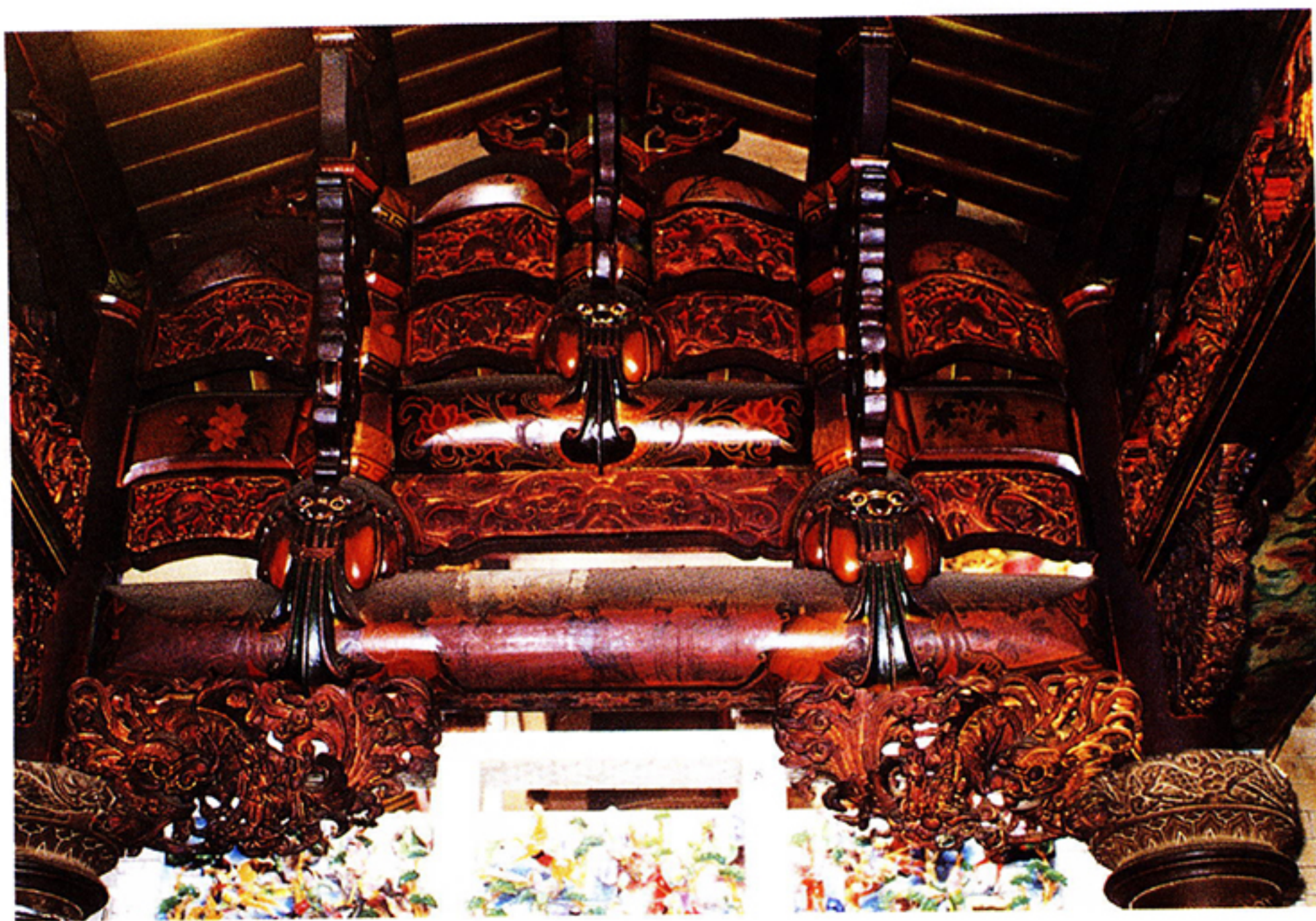
東港東隆宮拜殿棟架爲二通三瓜式，結構粗壯有力。
