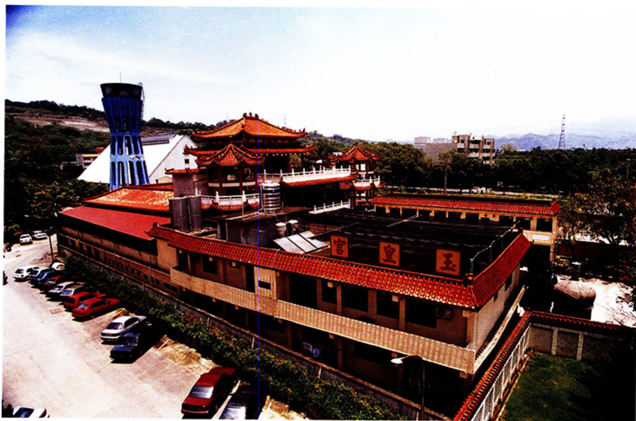
草屯鎮雙叉港玉皇宮的外貌全景
