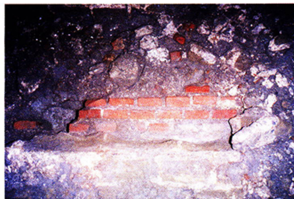
圖二一 第三道土牆底部紅磚共有五排。
