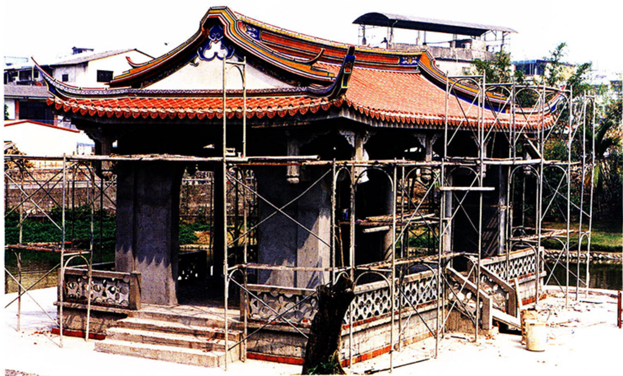
圖五 修建中之飛觴醉月亭（民八十九年四月）
