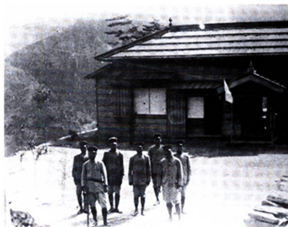
圖一一 駐在所之建築原型：平入、寄棟造、切破風、下見板 （魯崙駐在所） 來源：一九三三，《東臺灣展望》
