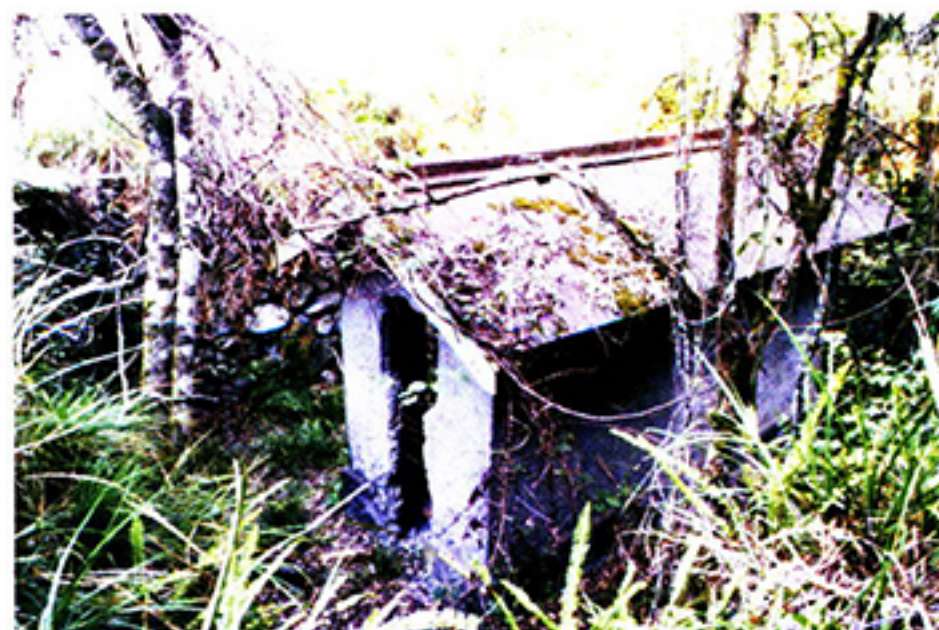
圖一二 鋼筋混凝土造的大分彈藥倉庫現況 攝影：顏亮平，一九九九
