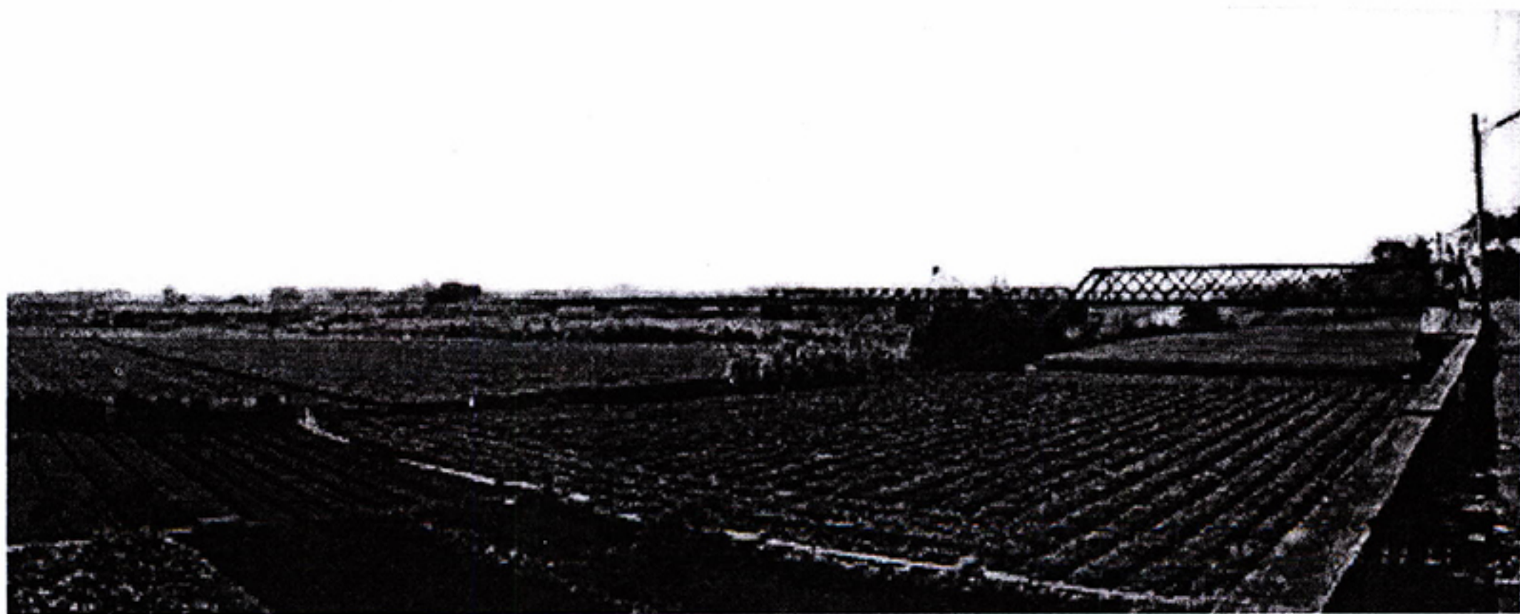
照片四—二 五間厝工場旁的虎尾溪鐵橋全景
