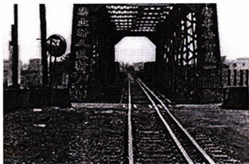
照片四—二 五間厝工場旁的虎尾溪鐵橋全景
