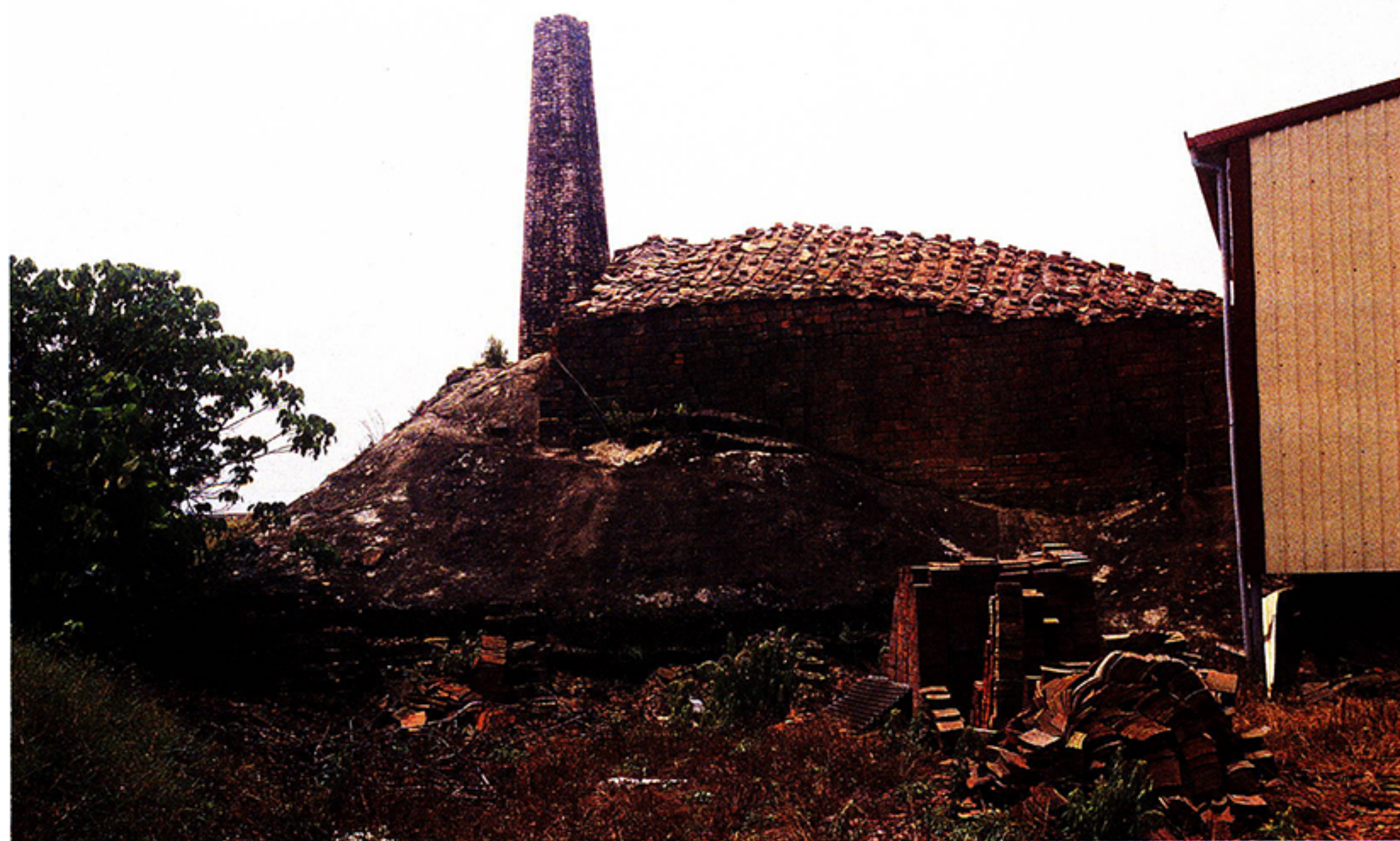
圖四一：臺南六甲磚窯是產業建築。
