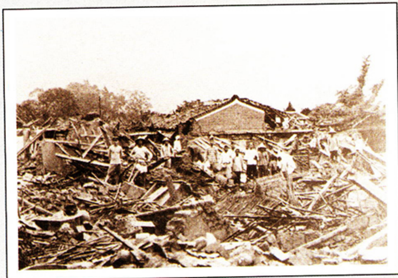
▲ 悵然若失的災民們在倒塌屋旁
