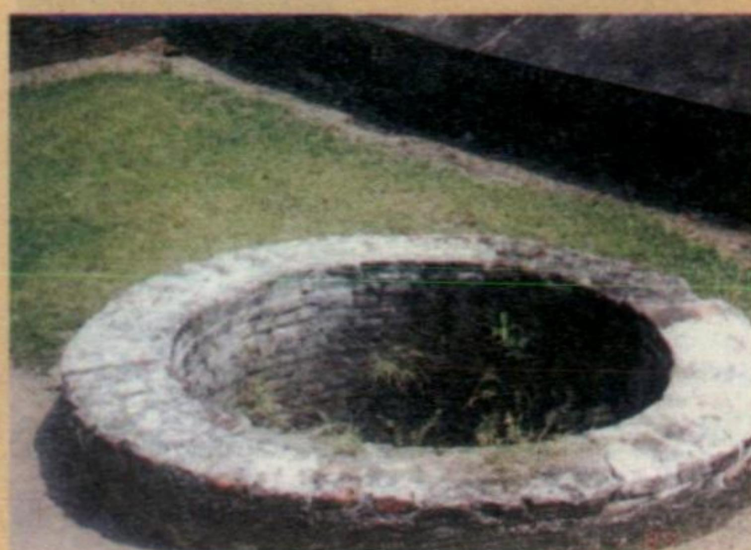
圖二 / 安平古堡砲台座古井，內徑1.6cm，由3.2cm薄磚結合蚵灰砌成，尚可看到貝殼粉粒敷材，續出泉。
