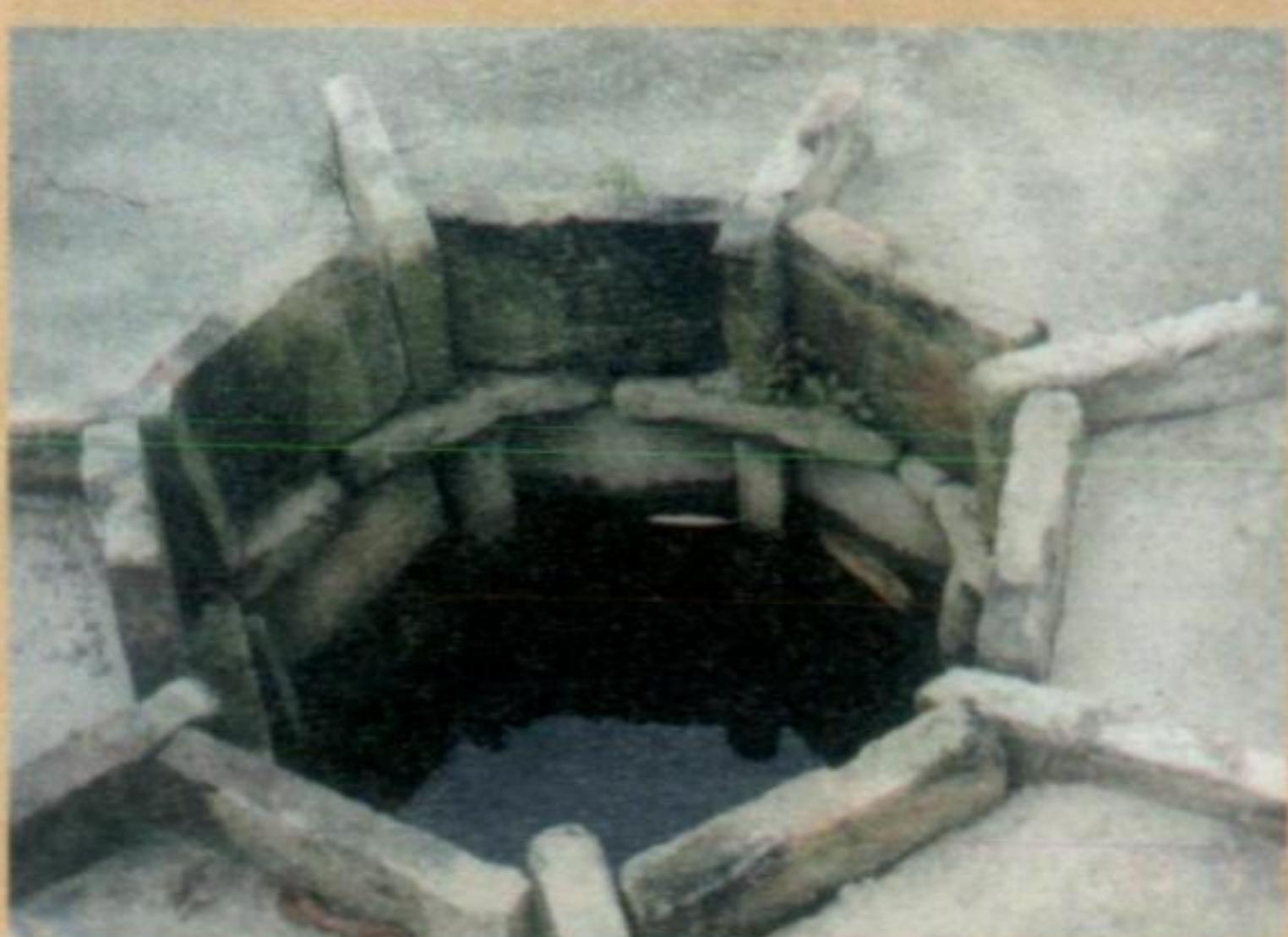
圖一 / 水林鄉車港村七邊磚井，直徑80cm，純由厚3.5cm烏磚交疊結構而成，未使用石灰結牢，續出泉。
