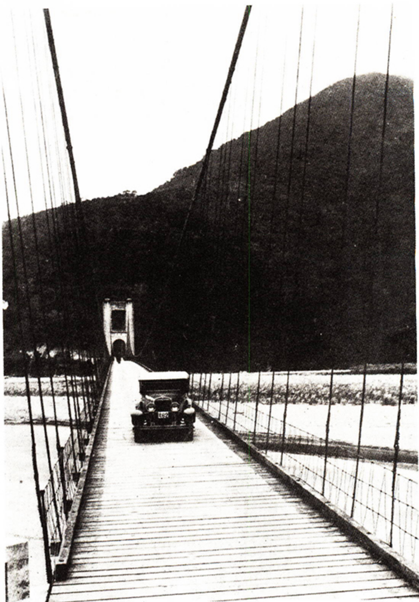
大濁水溪的鐵線橋：蘇澳至花蓮港間有長達一百二十公里的道路，是打通東洋第一大斷崖，經過多種困難而築成的。在其路上，跨越大濁水溪的這座鐵線橋，全長有五百五十公尺左右。
