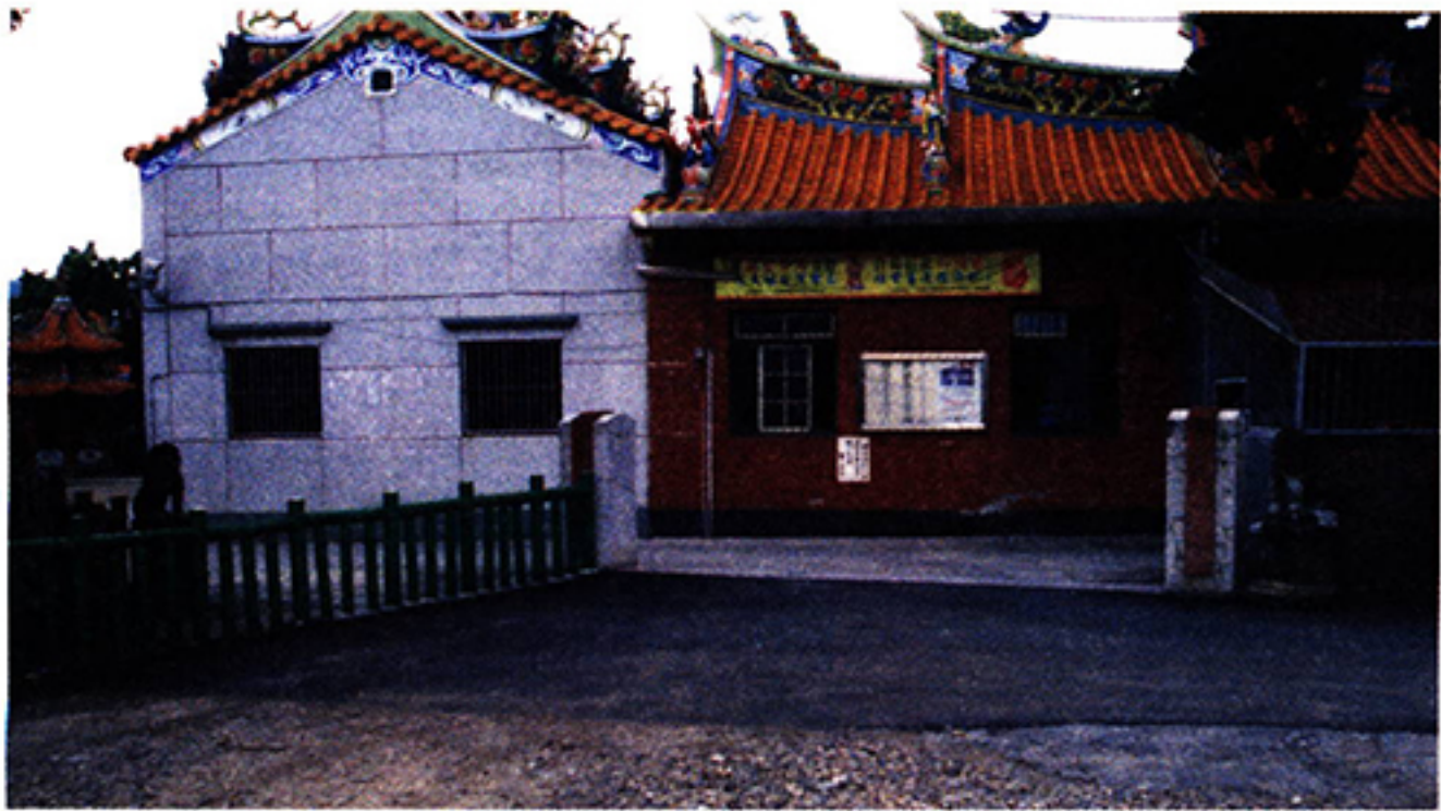
圖 10. 醒靈寺將能高神社狛犬放置於出入口兩側，惟一在牆外，一在牆內。另其排置方式與原神社擺置相反，本處擺置為兩隻狛犬對望，所以斜向方式擺置，而使狛犬稍微面向內側。
