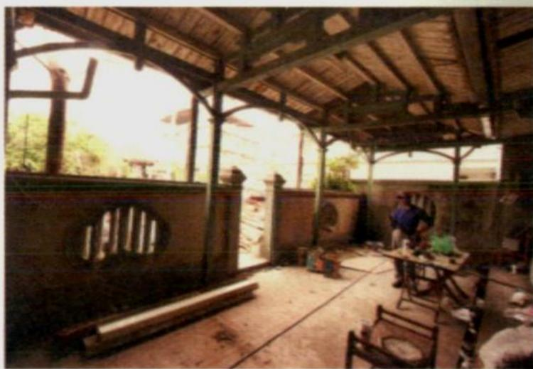
圖2 清水楊天賦宅左外護龍內圍牆和雨遮棚架
