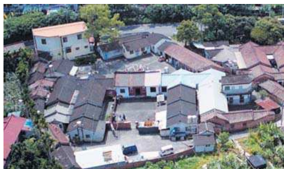
圖35：一堂四橫屋帶方形圍聚牆頭屋及門樓空拍圖（已不存）
