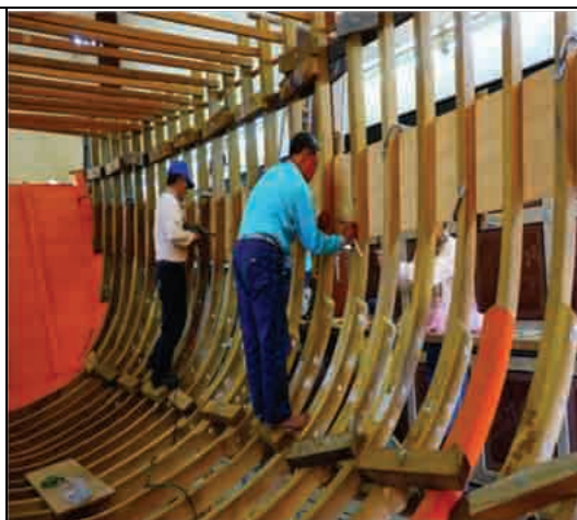
圖 4-10 於大波內外側鑽螺絲孔固定
