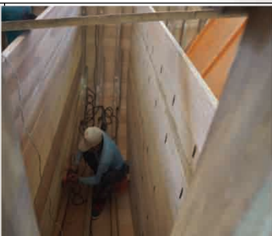
圖 4-14 隔艙板疊起再以扁釘固定
