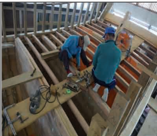
圖 4-16 船拱、抽、船艙口施作
