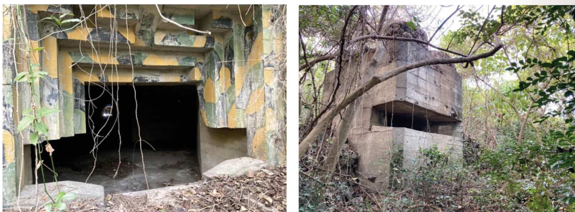
圖 10 潭頭山東側軍事遺跡現勘照片組 資料來源：宋德威先生提供。
