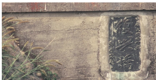
圖 40 修復完成的「復興橋」銘刻
