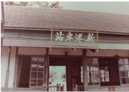
圖 45 拆除前的新港車站
