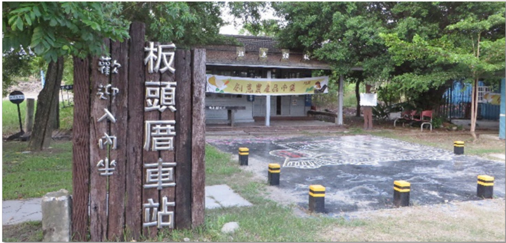
圖 51 重建整理後的板頭厝車站
