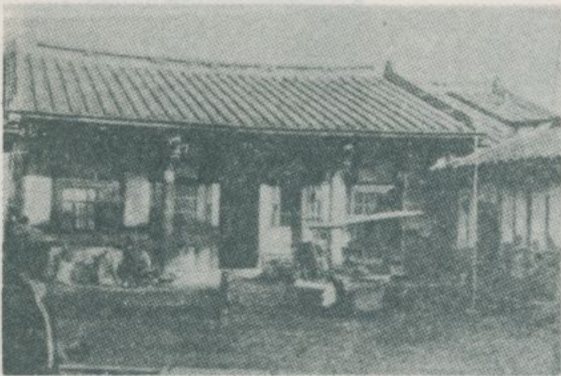
普，材木產盛因。宅住式舊的鎮山竹 。造建木檜用使量大也房民通
