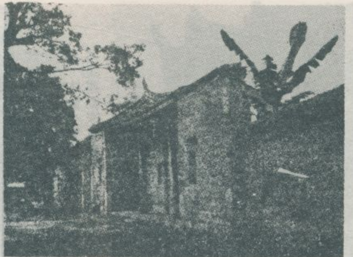
潰倒已，廳門邊左「厝下」該：〇一圖 。是皆處到，壁殘垣斷，半大
