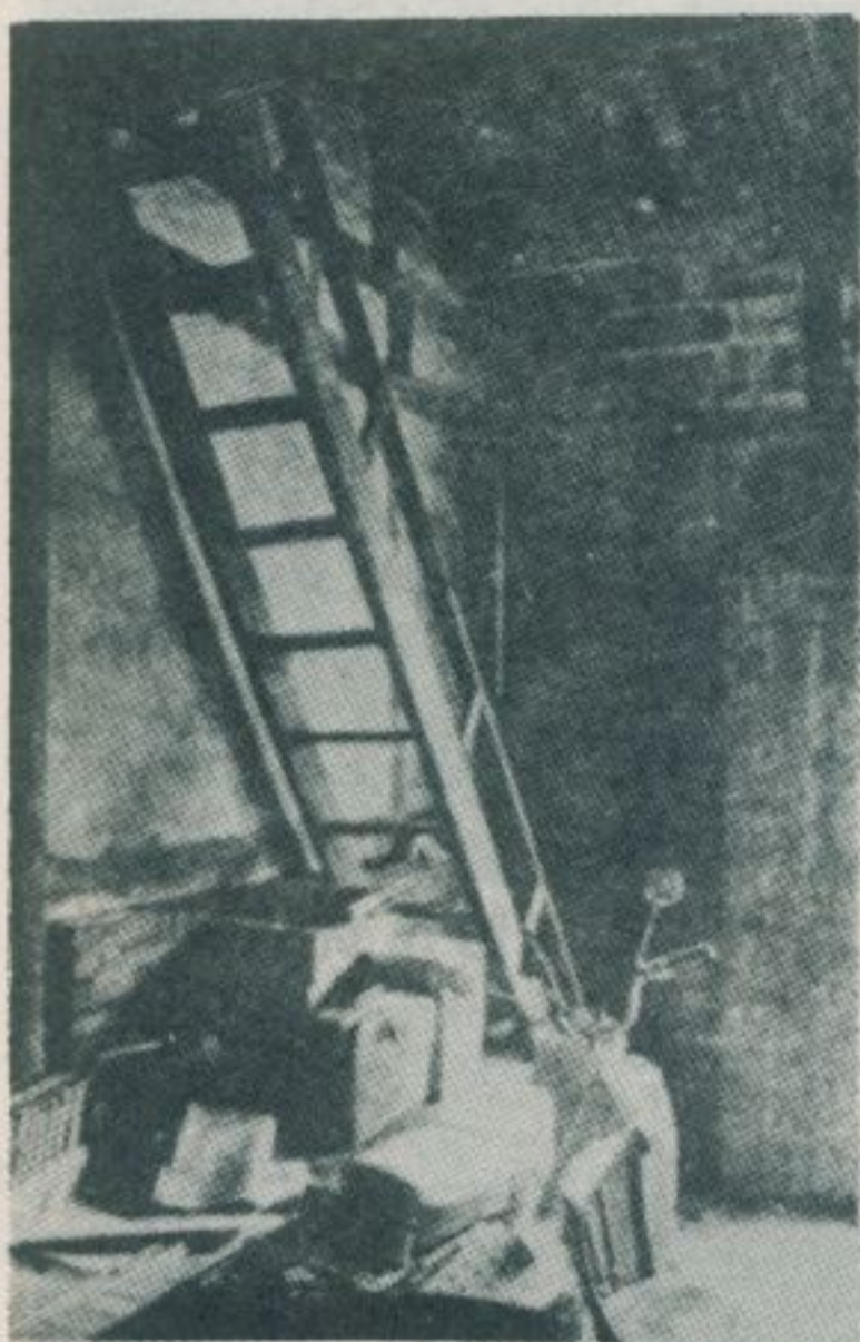
新民路四四號店舖內的樓梯
