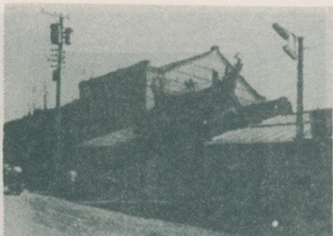
。爺王府金奉供，館安萬鎮斗北
