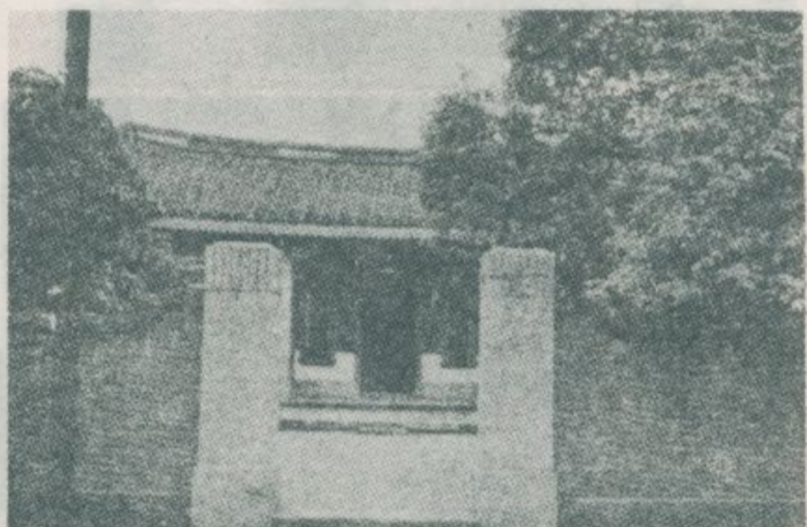
廳正的宅林厝家頭鄉子潭縣中臺郊市
