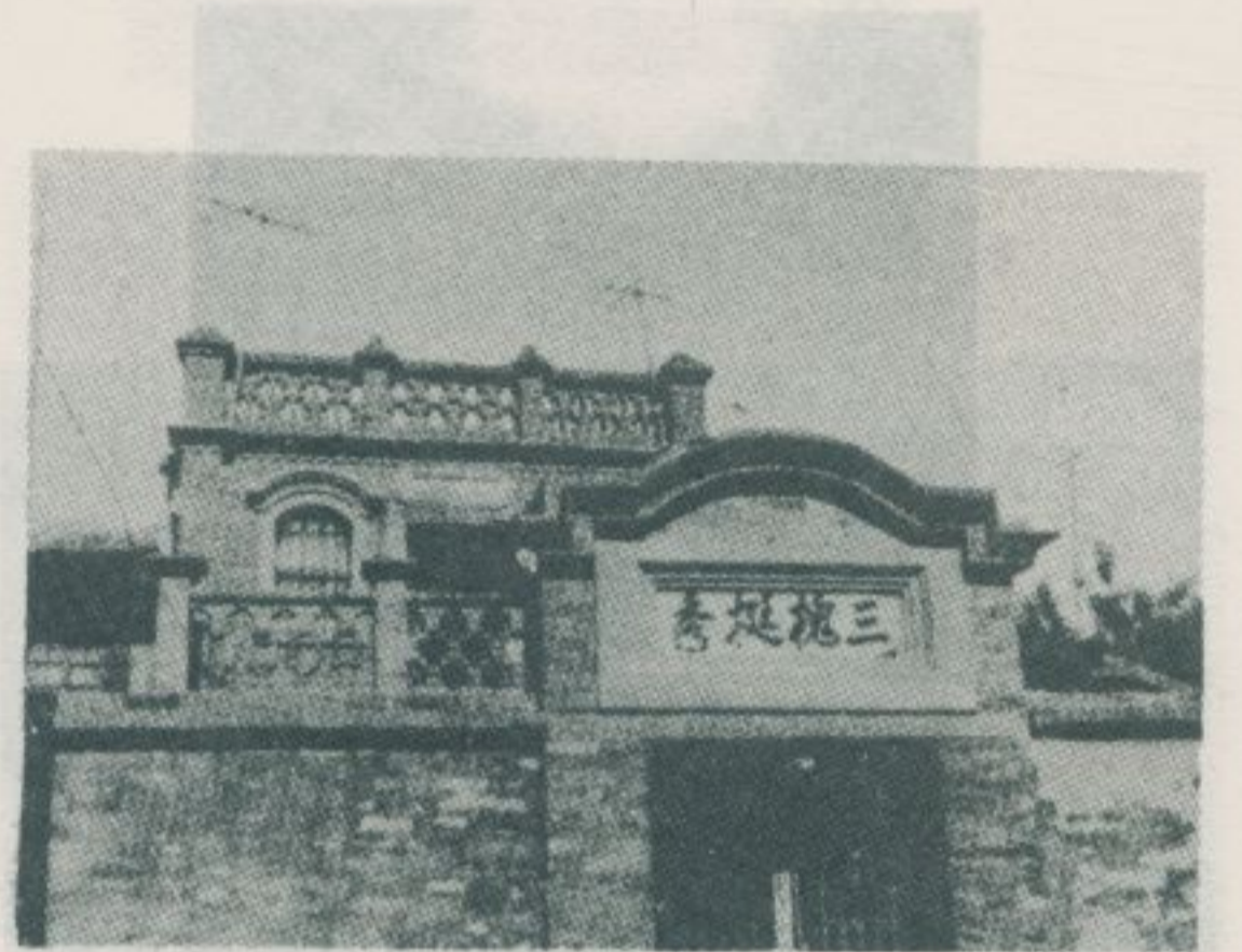
房 民 之 造 建 期 時 據 日
