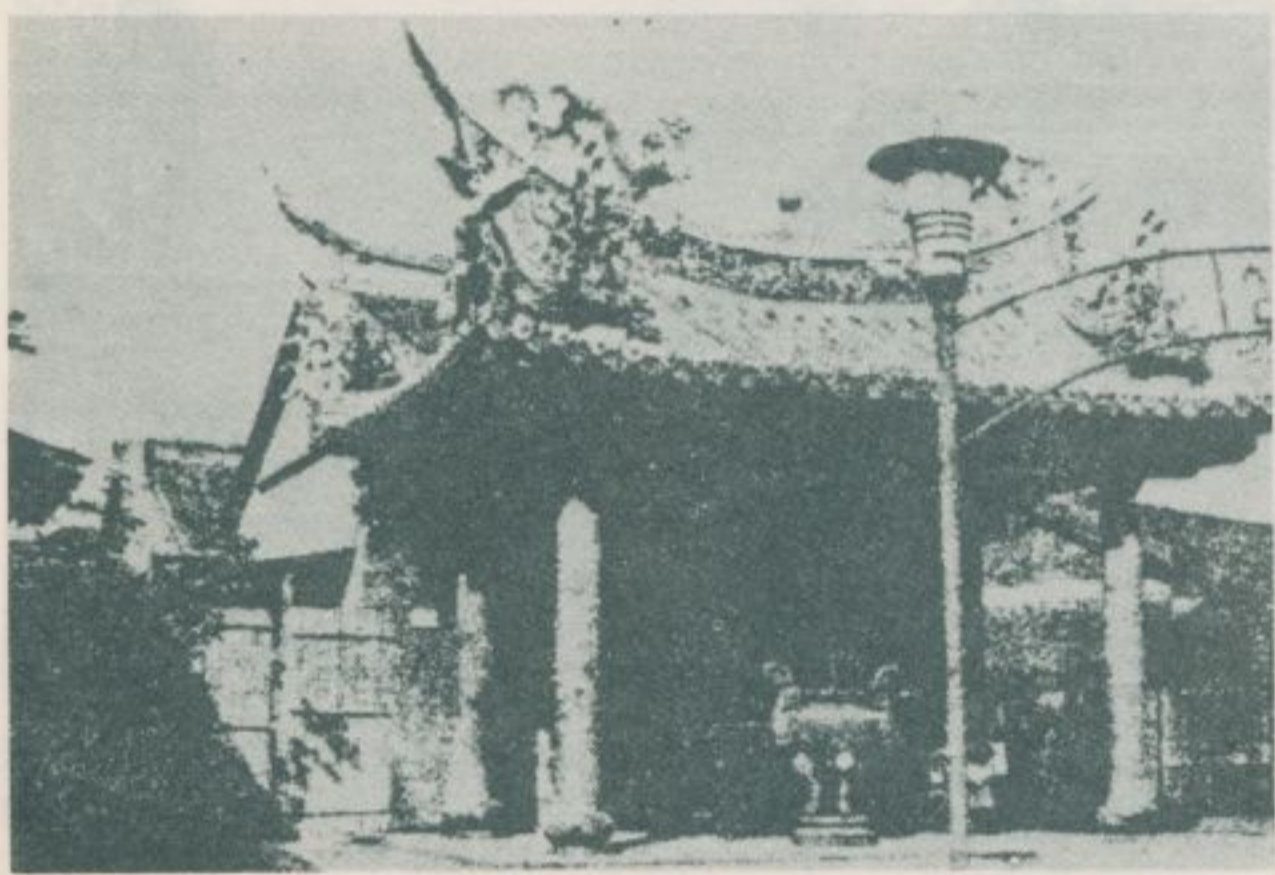
廣照禪寺正殿
