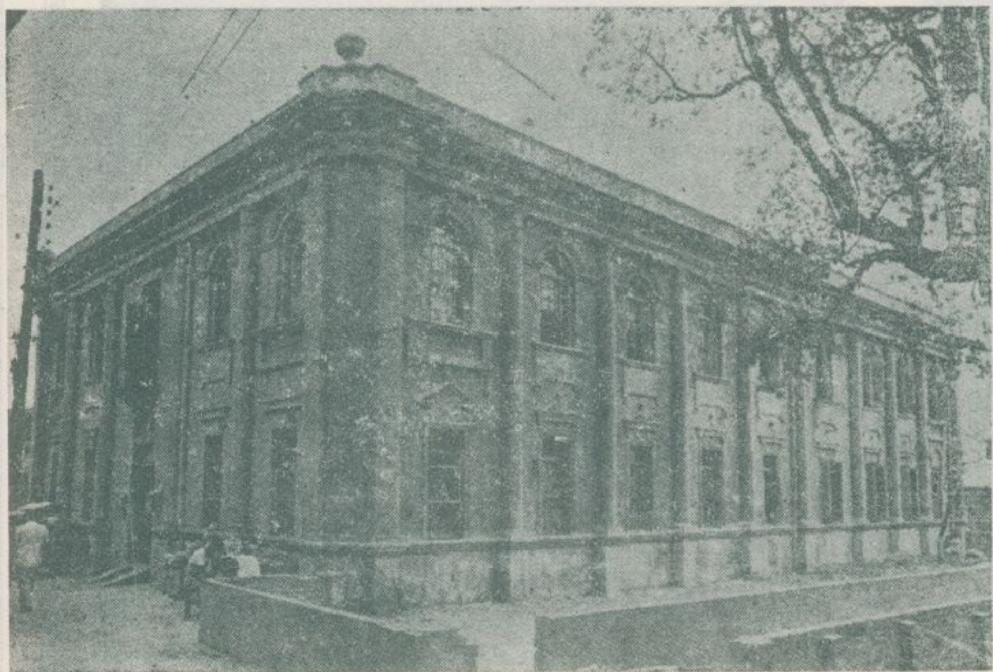
涼州街一三四巷六〇號樓屋，亦係日據初期洋房建築之一典型。
