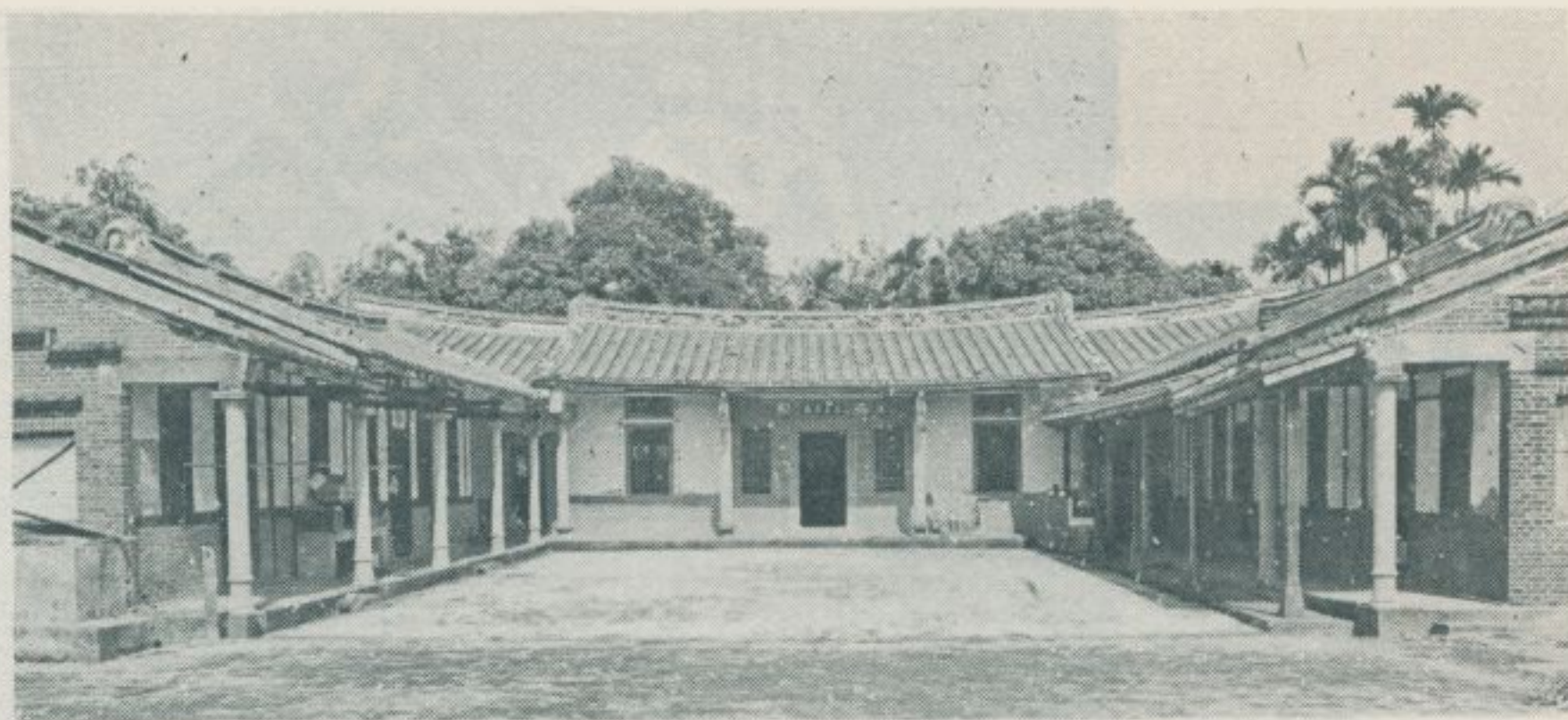
宅劉號四二路橋板
