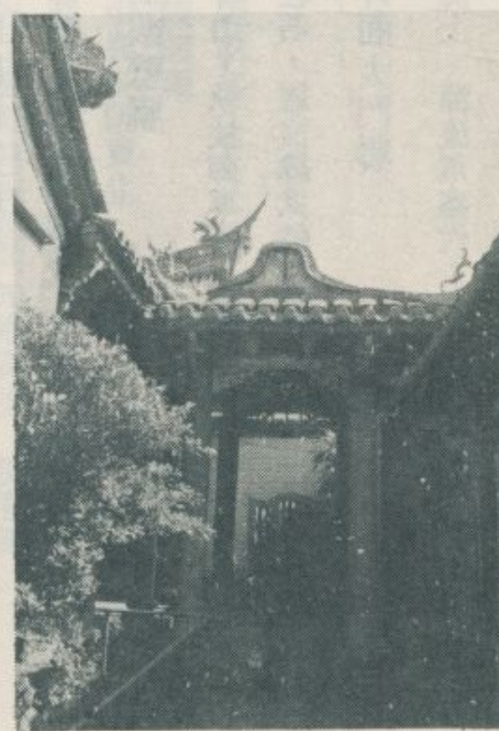
景側的殿正和門川山
