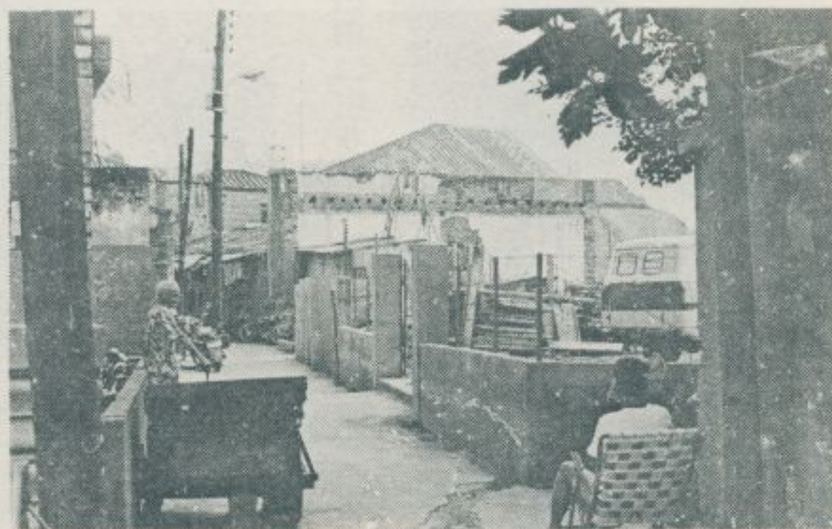
涼州街134巷古洋房的斷垣殘壁
