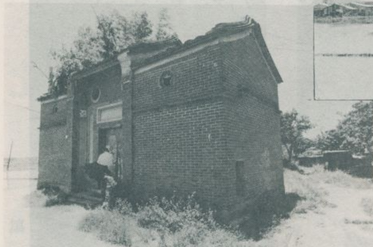
賴宅尊德堂大門
