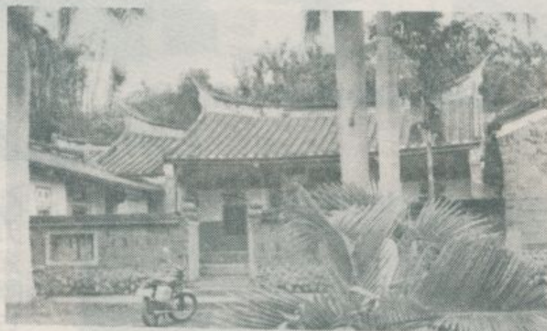
新埔鎮上枋寮二八七號劉宅
