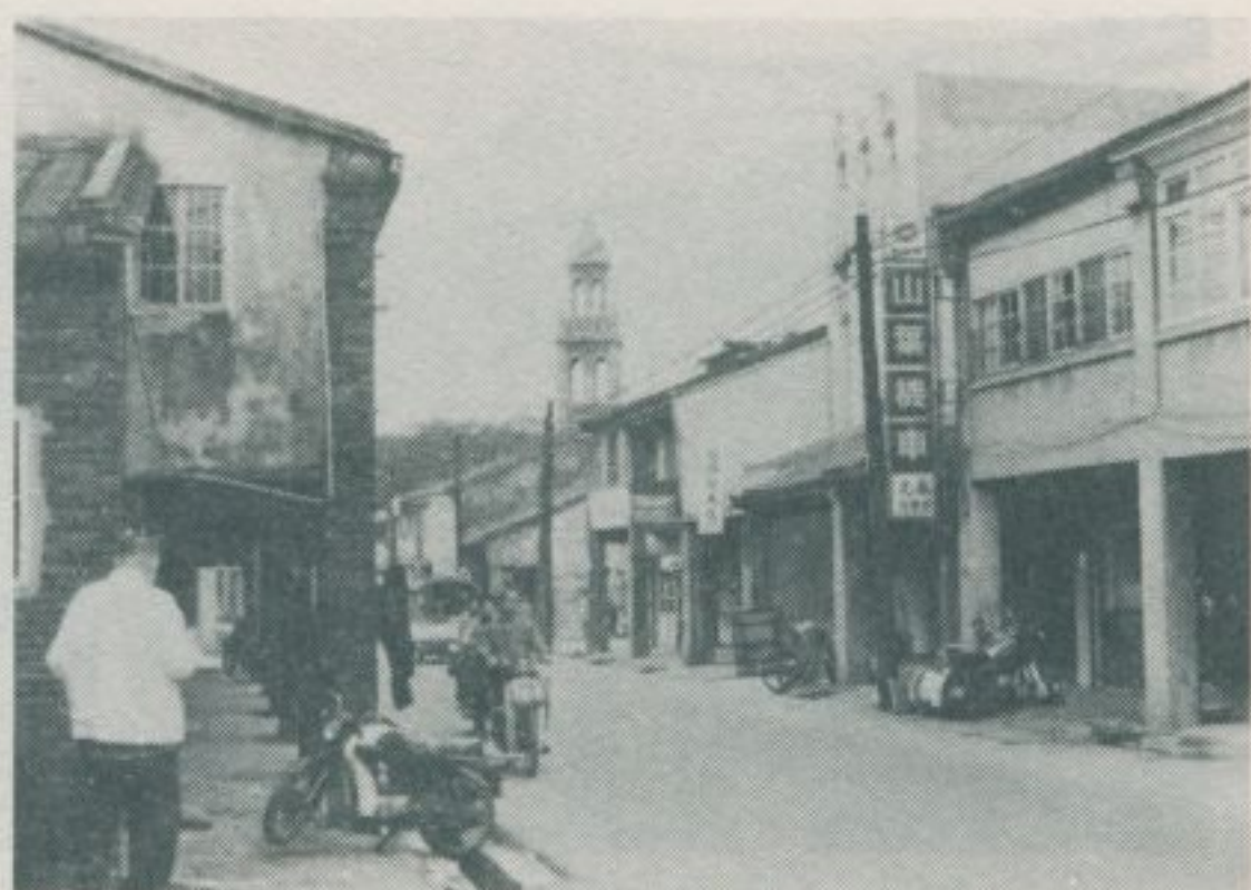
道街的路正中治鎮埔新
