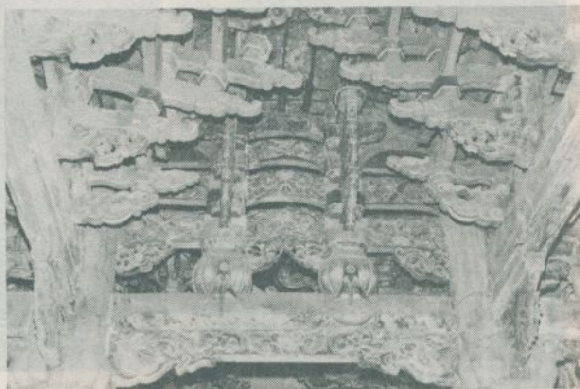
走廊的畫棟彫樑
