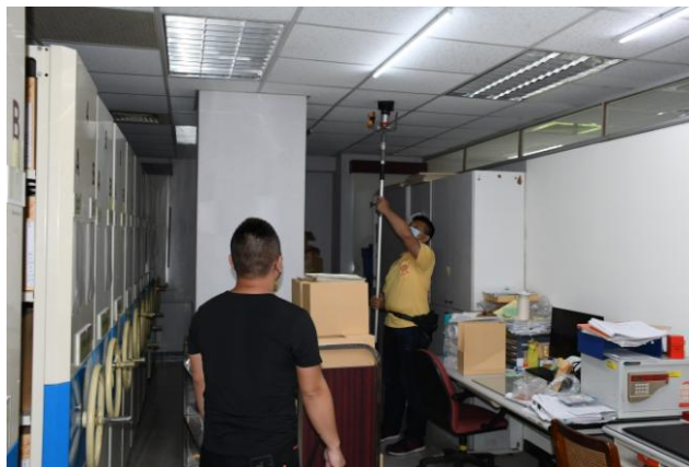
(1-2) 尚奕電業工程有限公司技師進行偵煙器觸發
